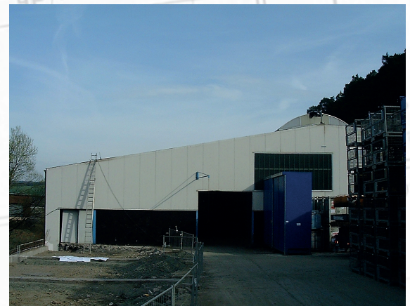
Werk I - Hallenanbau
